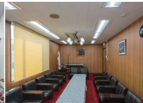
会議室 TENQOOシリーズを採用し、リニューアルプレートを用いて旧器具の設置跡をカバー。
