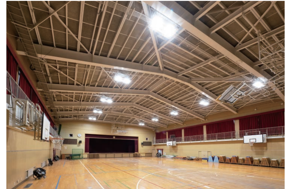
明治小学校体育館の照明 既設器具(メタルハライドランプ器具)からLED高天井器具②に更新。100%全点灯時で580ルクスの平均照度を実現。
