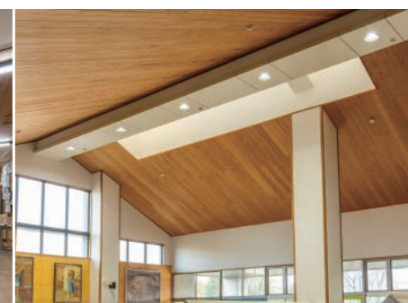
昇降口 LED一体形ダウンライト⑥による照明。
