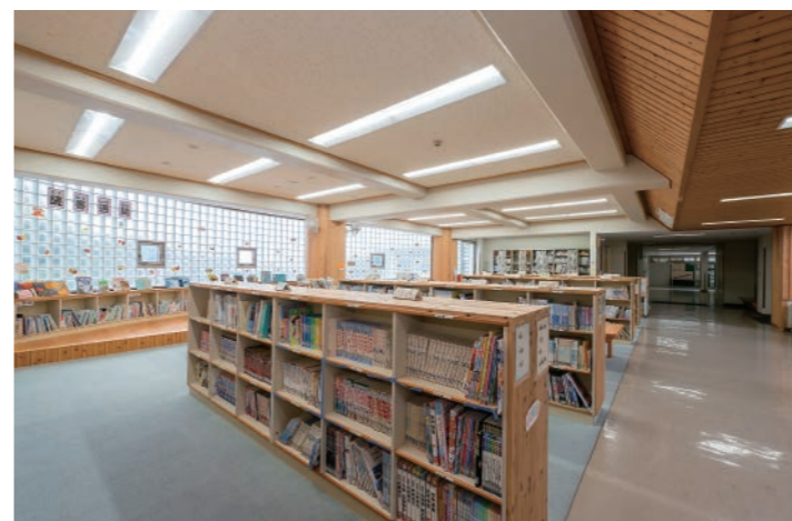
図書コーナー(大窪小学校) LEDベースライト①とLEDダウンライト④による照明。
