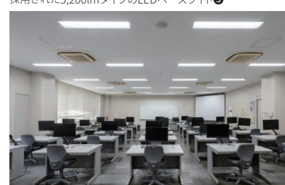
(南大阪)化学ビジネス科の照明 本館管理棟1階の実習室に採用された5,200lmタイプのLEDベースライト③
