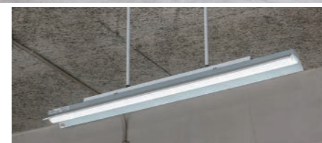
① LEDベースライトTENQOOシリーズ40タイプ直付形反射笠
