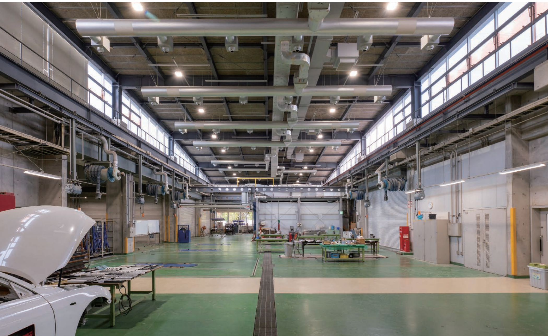
南大阪高等職業技術専門校/自動車・車体整備科実習場の照明 400W形メタルハライドランプ器具相当のまぶしさ低減タイプLED高天井器具①を2列×9灯設置。陰になりやすい壁際にはレースウェイ設置のLEDベースライト②で明るさをプラス。
