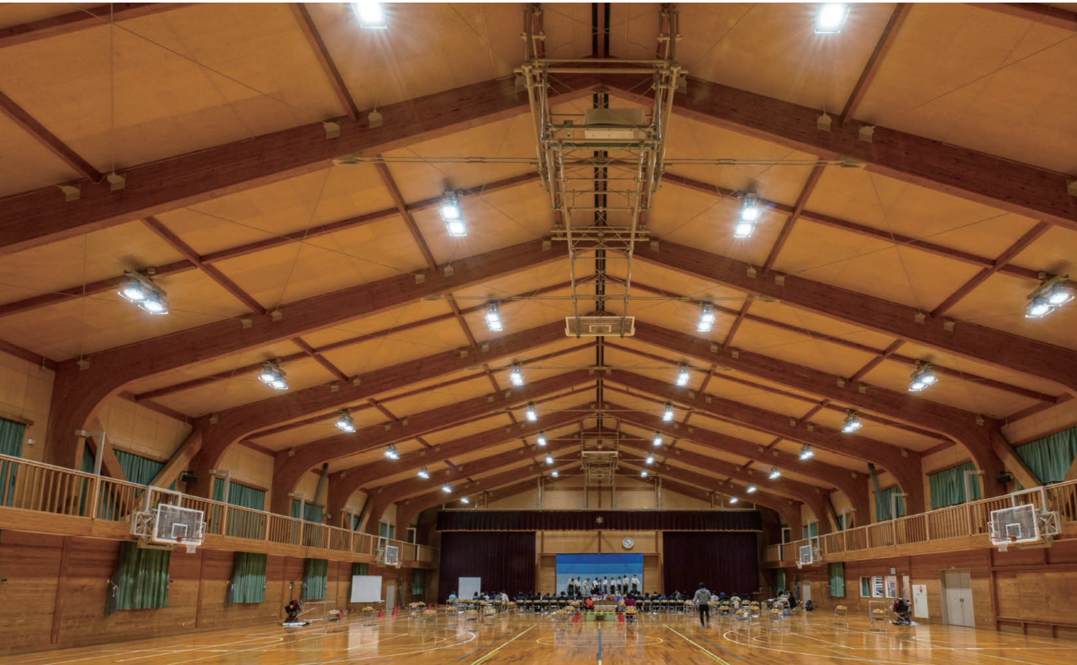
体育館 LED高天井器具①による照明。
