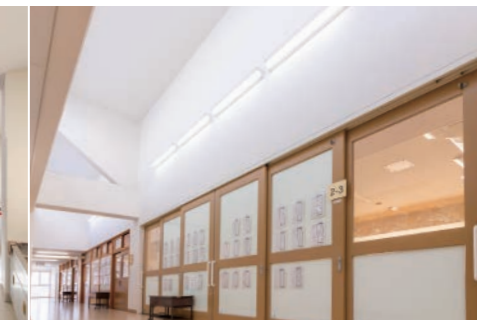
教室前廊下の照明 既設の間接照明に換えてLEDコーナー灯⑥を16台設置。
