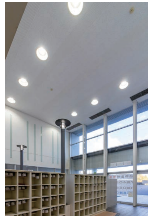
図書室の照明 折り上げ天井にLEDスクエア器具④を計18台採用。
