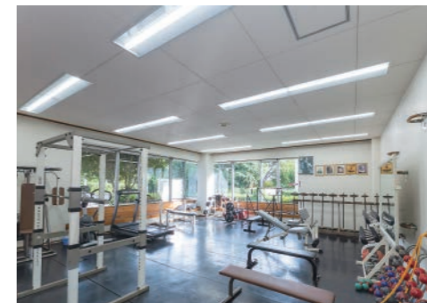
トレーニング室 TENQOOシリーズ埋込形の連結用器具⑥を2台連結で配置。
