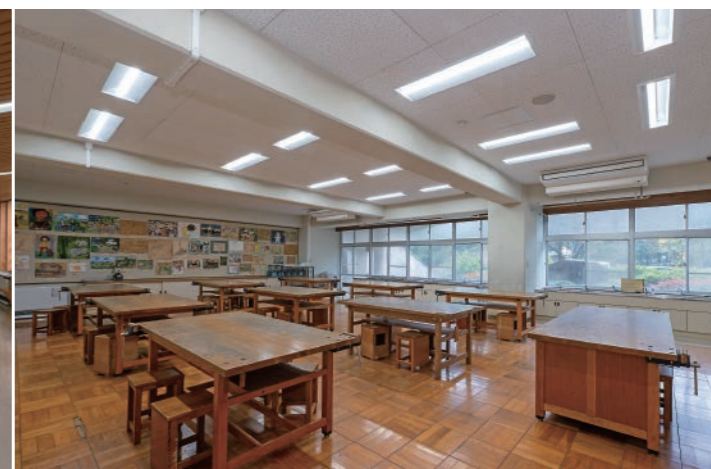
図画工作室(大窪小学校) LEDベースライト①と黒板灯③による照明。
