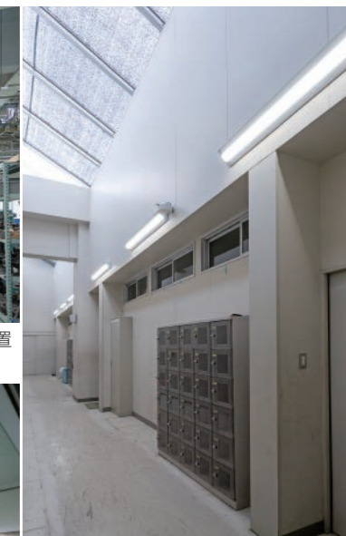
(南大阪)実習棟北棟の照明 直付形のコーナー灯④を設置。
