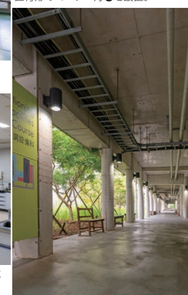
(南大阪)外部通路の照明 明るいクラス700のユニットフラット形ランプと組み合わせた円筒形LEDブラケット⑤
