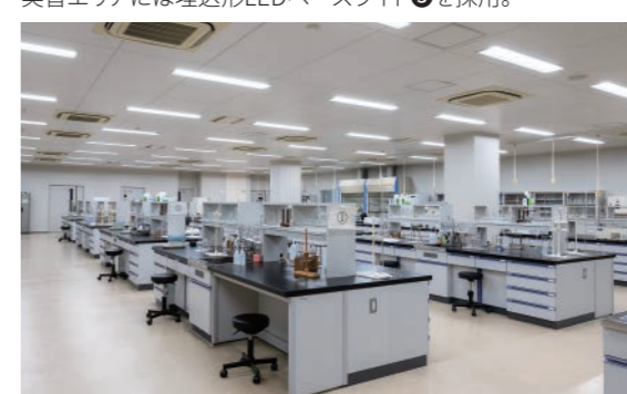
(南大阪)化学ビジネス科の照明 本館管理棟1階の実習室に採用された5,200lmタイプのLEDベースライト③
